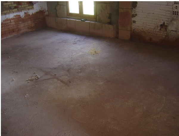
Finalització de l'estesa del paviment.
